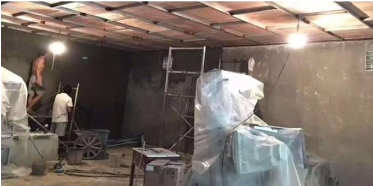
射线防护材料有各种类型各种材质，不管是公立的医院放射科还是私立的口腔医院、牙科门诊、宠物医院[x光室]ct室、dr室、手术室等选择质量的防辐射原材料和有经验的防辐射工程队伍做相关装修非常重要，根据国家要求带有放射源的机械设备房间都需要第三方职防院检测合格方可运营。为了避免检测不合格造成不必要的麻烦比较好选择较好的防辐射原材料和有经验的防辐射工程施工队，一般做防辐射材料或防辐射工程的公司都有原材料的检测报告而且每年复审一次，采购相关防辐射材料时可参考这一点。常用的防辐射材料有：铅板、硫酸钡、铅门、铅玻璃、铅屏风、铅房、铅箱、铅胶皮、防辐射服等。25
